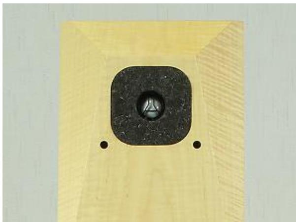
羊毛氈高音阻尼的用途是吸走高音單體周圍的繞射。
